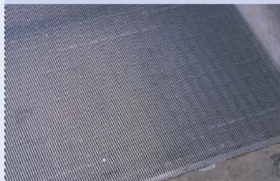
Oberfläche des Wedge-Wire-Screens
